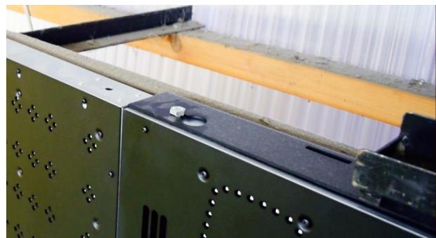
3) Ziehen Sie die Schraube (C) fest, um die Anzeigetafel am Wandbefestigungswinkel zu sichern.
