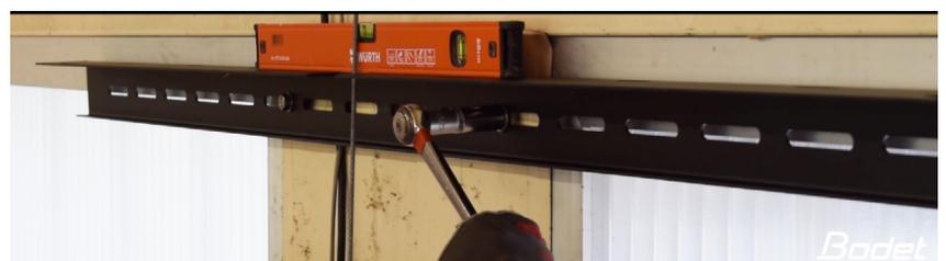
2) Befestigen Sie die Anzeigetafel am Wandbefestigungswinkel, indem Sie sie in die tropfenförmigen Öffnungen (B) schieben.
